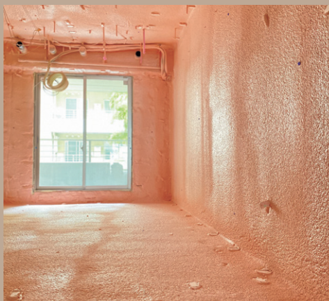
断熱施工の様子
